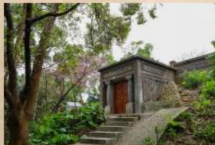
中和 瑞穗配水池
